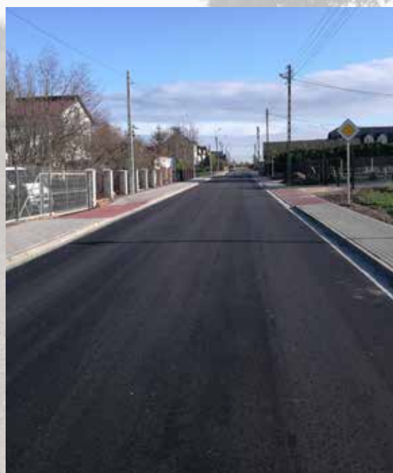
Remonty dróg w mieście i gminie Żelechów. 2019 r.
