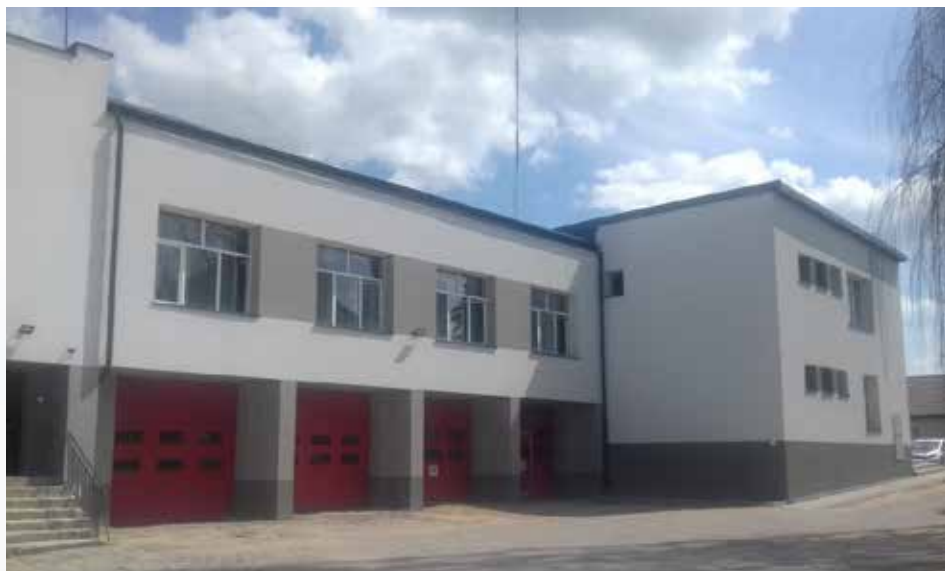
Termomodernizacja budynku MGOK.
