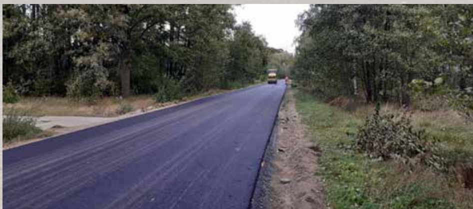
Przebudowa drogi w Starym Goniwilku. 2019 r.
