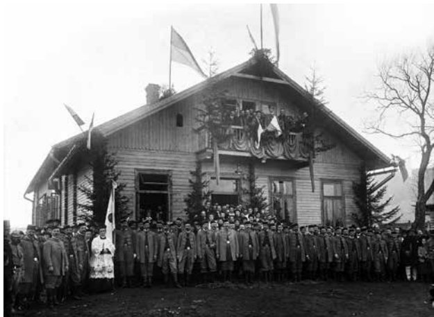
Budynek sokołni, Zakopane, 18.04.1909, arch. Eugeniusz Wesołowski (TG Sokół Zakopane)
