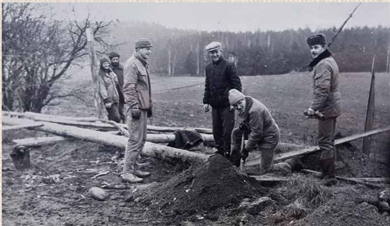
Budowa ambony przy żwirowni w Brejdynach, rok 1990
