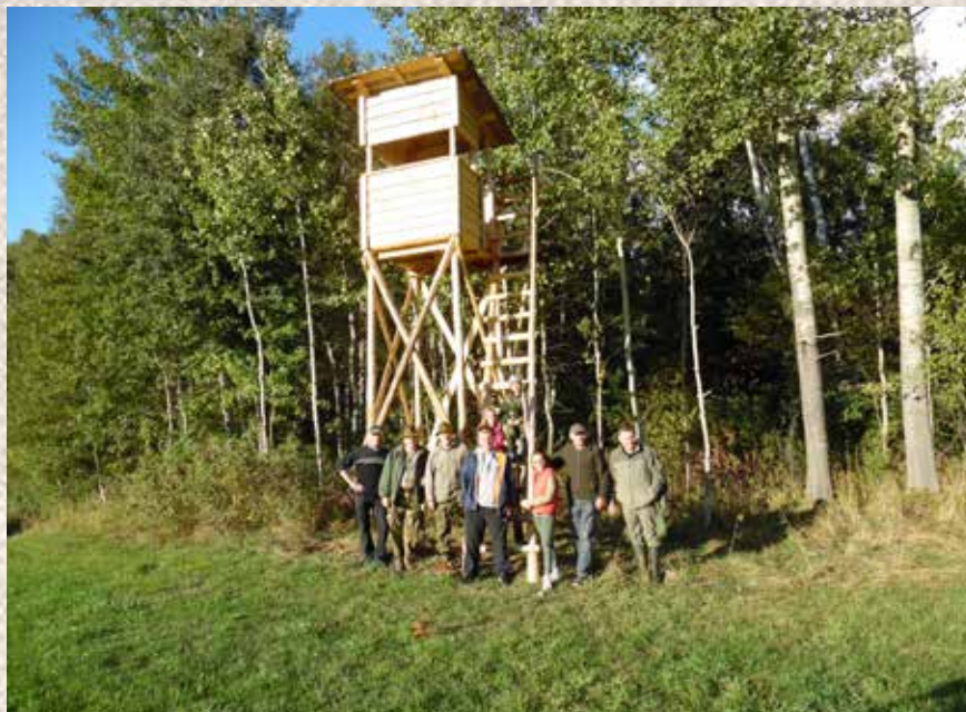
Po zakończonej budowie amobny przy Bagnie Smoka
